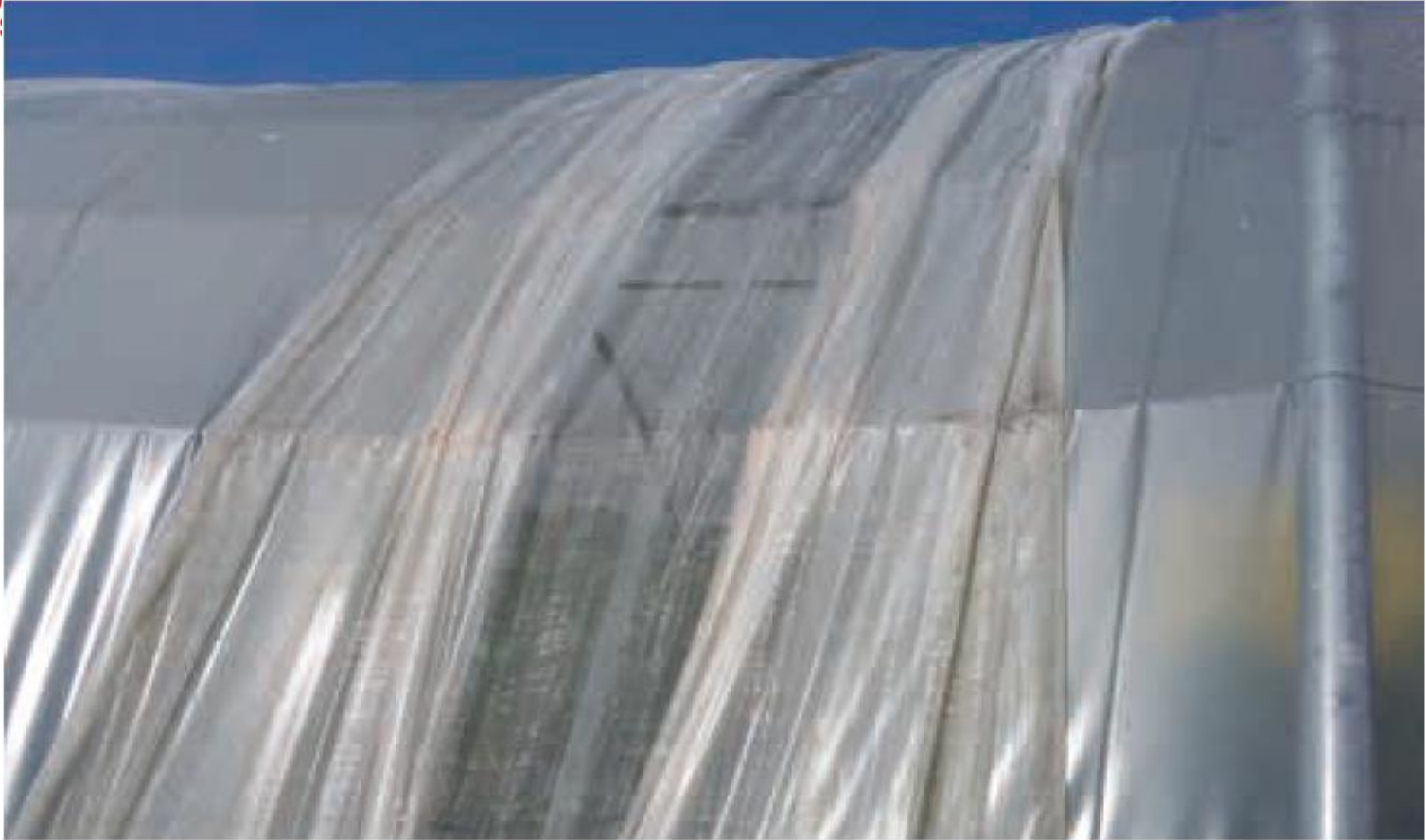
> PHOTO 19: EXEMPLE DE FILET SUR UN OUVRANT DE TUNNEL PLASTIQUE
